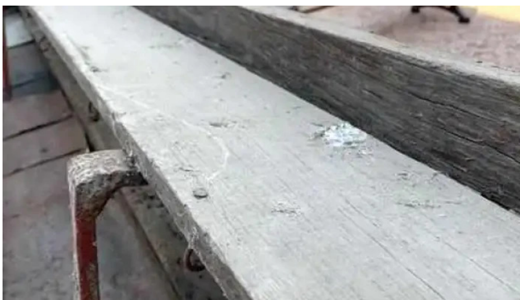
Ganchera de pinchos p pared 180 2
