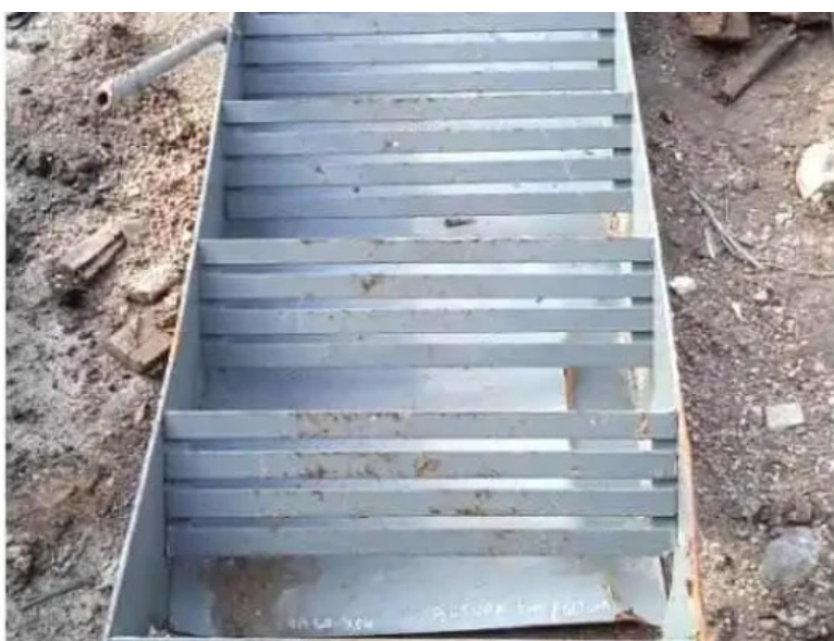
1 escalera de hierro 13 03 2021
