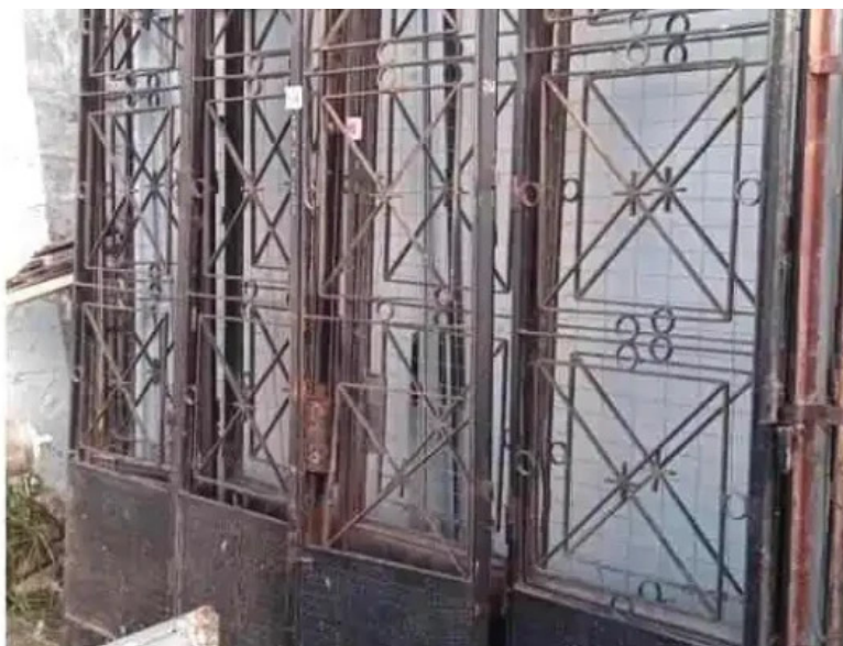
1 porton de garage 13 03 2021
