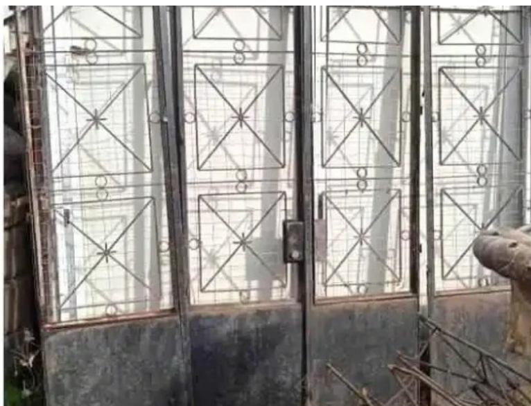
1 porton de garage 13 03 2021
