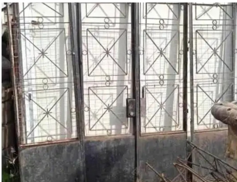
1 porton de garage 1
