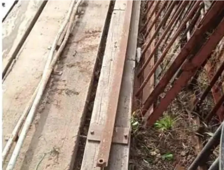
1 viga de madera 1
