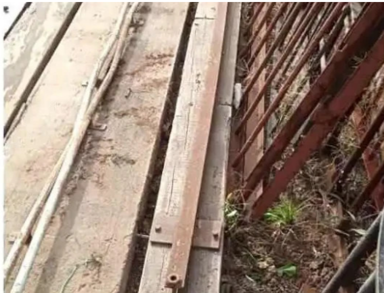
1 viga de madera 13 03 2021
