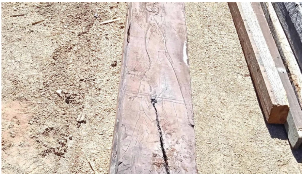
3 vigas de madera dura 1
