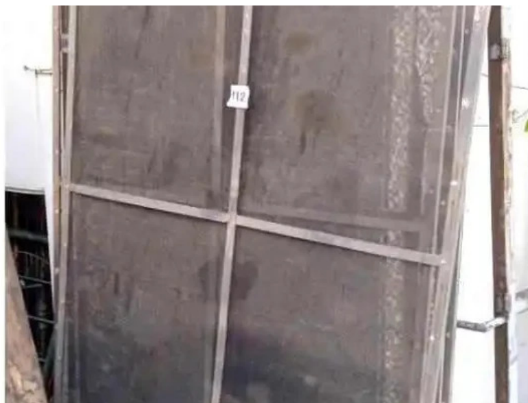
4 paneles con malla 1
