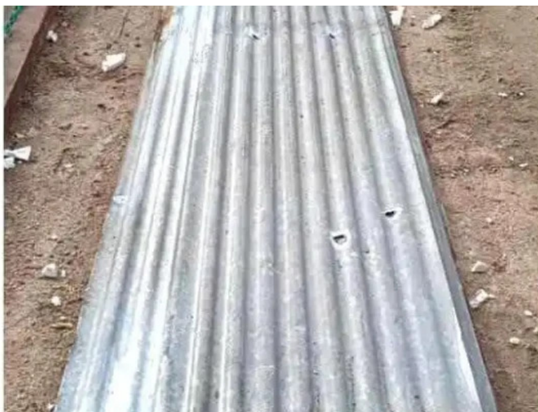
5 chapas de zinc 13 03 2021
