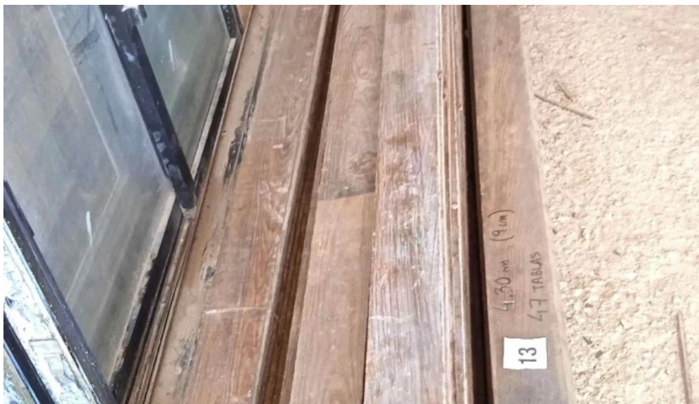
Piso de pinotea 18 m2 aprox 1
