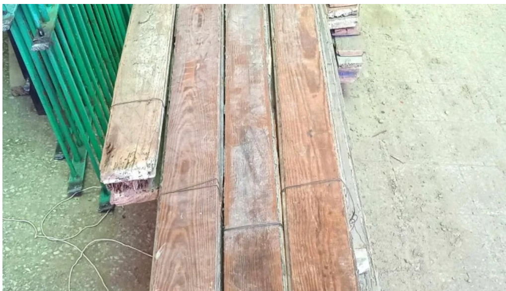
Piso de pinotea 30 m2 aprox 1
